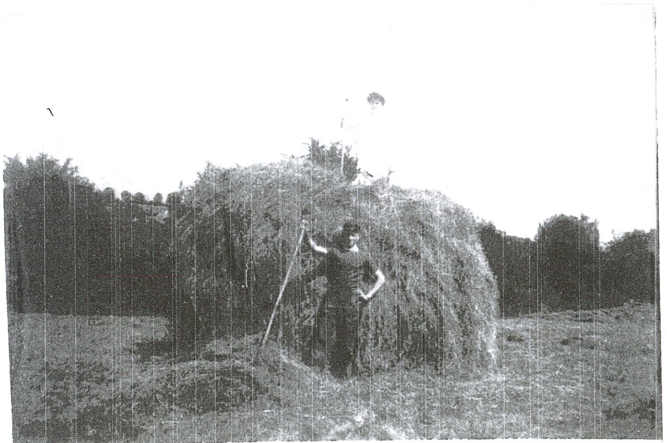
Le mulon est terminé
