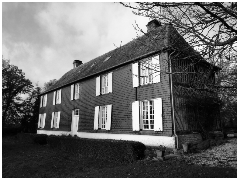
Le manoir d'Houlbec, côté sud-ouest.
