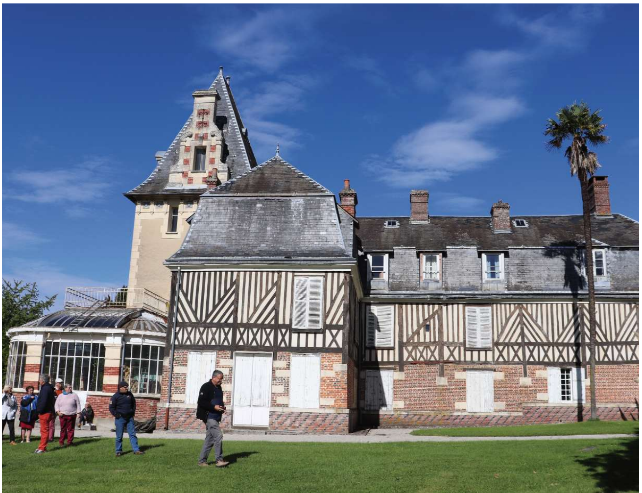
La façade arrière était autrefois celle de l'entrée. A gauche, la grande verrière.
