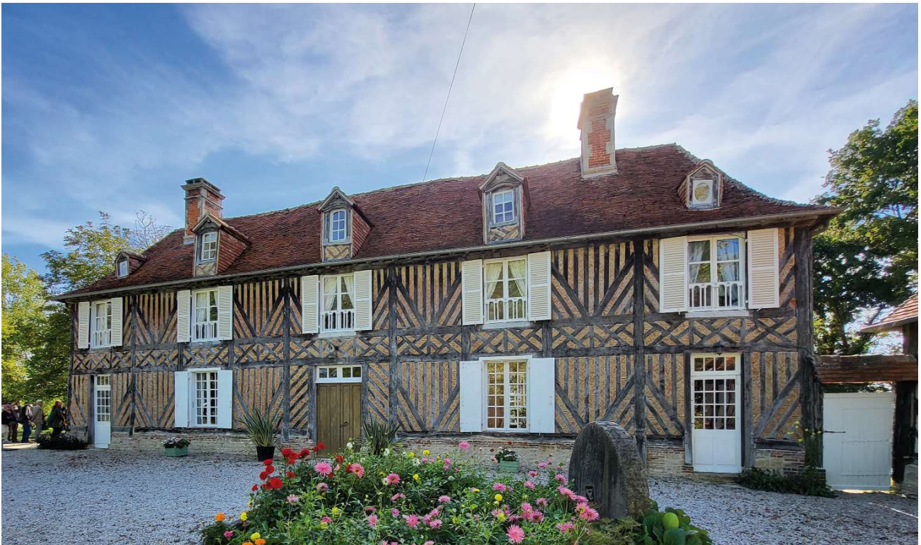
Le manoir d'Houlbec – façade nord-est.
