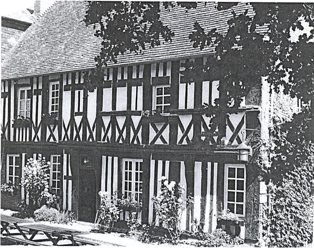
de l'étage s'encastre dans l'épaissement des poteaux longs et dans les tenons ménagés en épaisseur des poteaux courts de l'étage. Elle détermine une allège en croix de Saint-André constituées d'écharpes assemblées et une série de baies en partie obturées. Deux portes ouvertes sur l'extérieur se faisaient face dans une même travée de l'étage.
